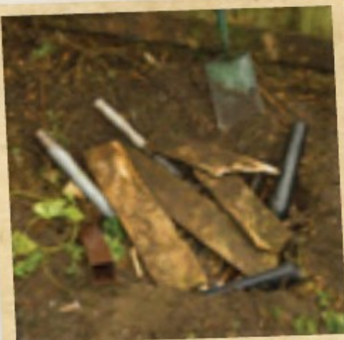
Madeira e posicionamento dos tubos
