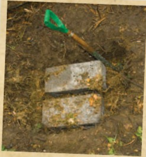
Blocos de cimento em cima da gravilha, lado a lado
